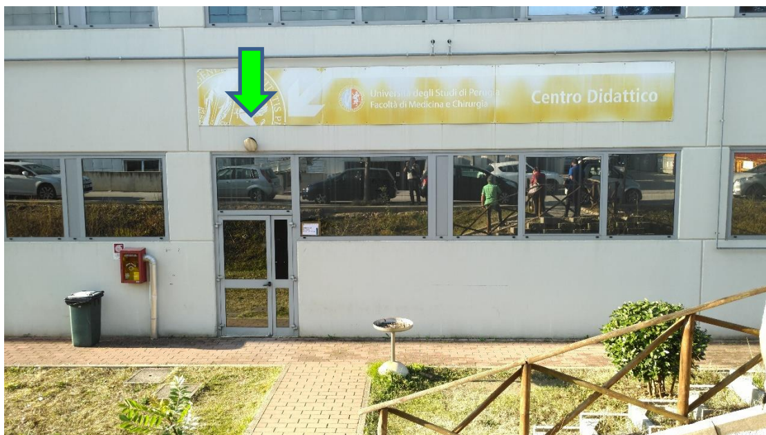
INGRESSO PRINCIPALE EDIFICIO B1
