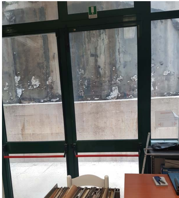
Uscita di emergenza lato sud piano seminterrato
