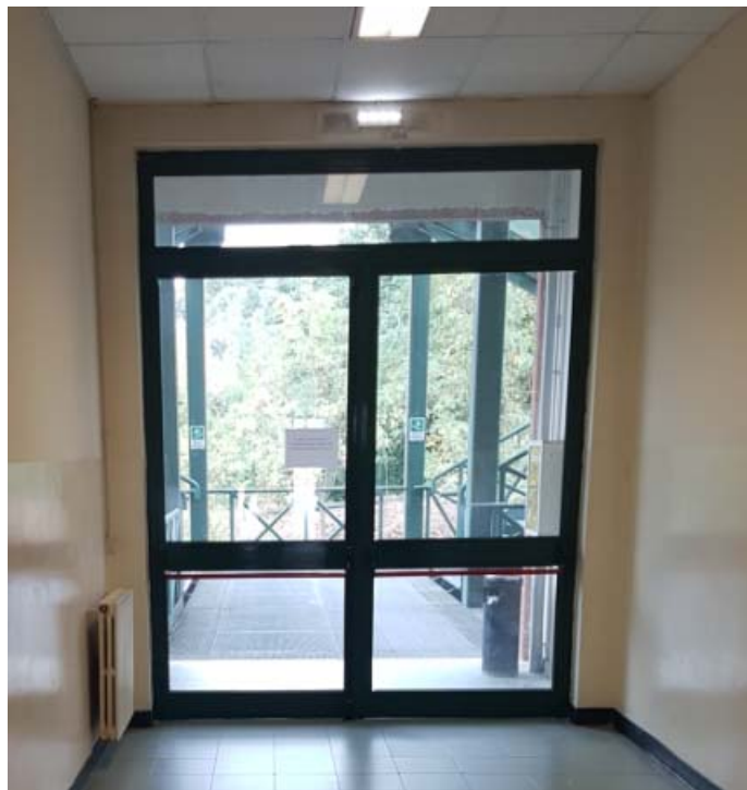
Uscita di emergenza verso la scala esterna- piano terra
