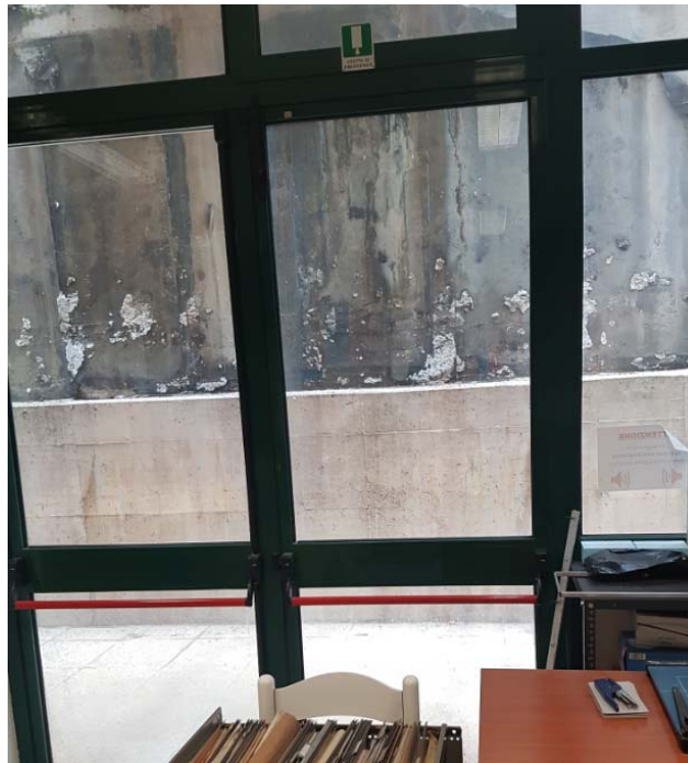
Uscita di emergenza lato sud piano seminterrato
